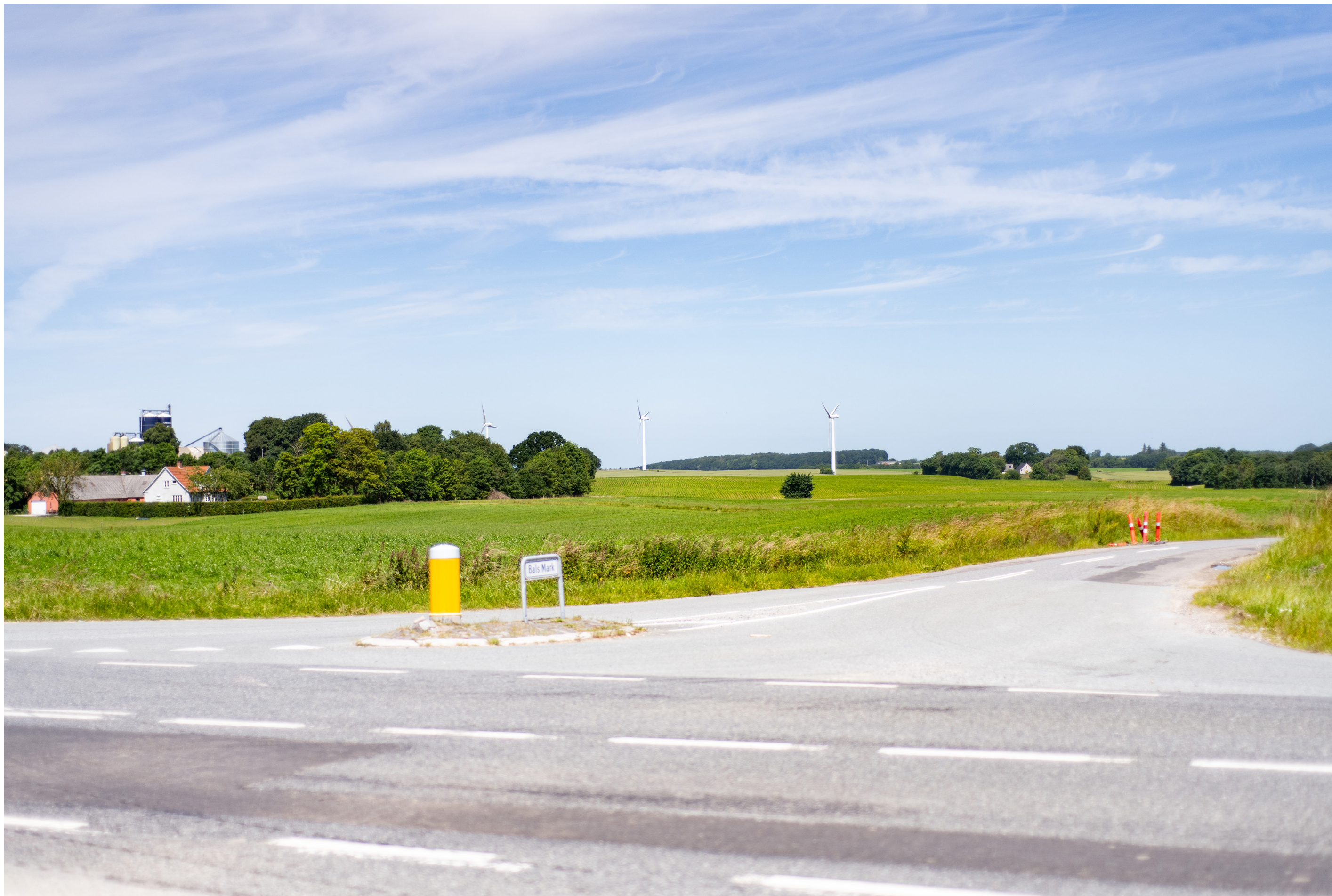
05 Kaløvej og Balsmark vejkrøds, set mod nord, eksisterende forhold
