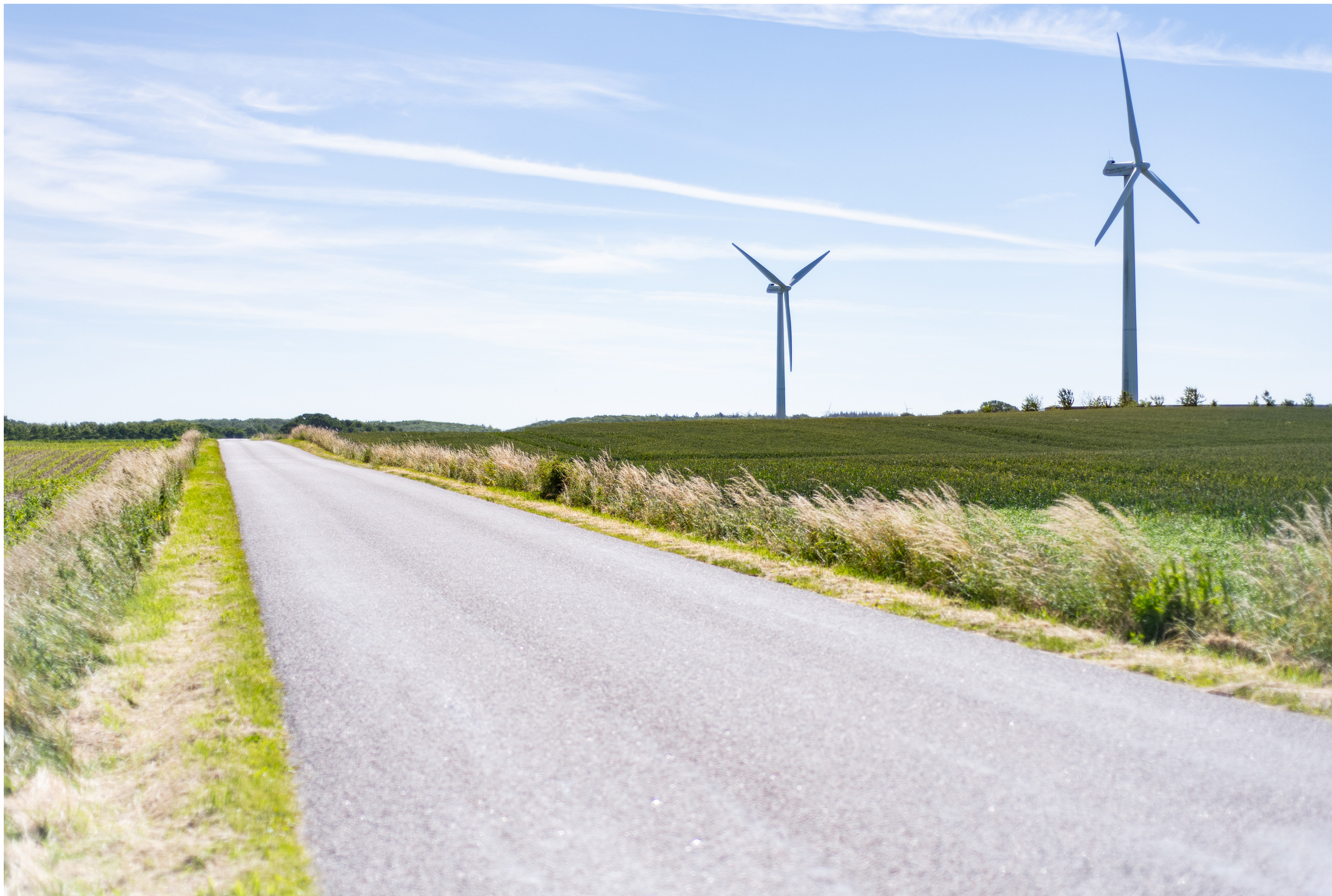
02 Estrupvej midt, set mod sydøst, eksisterende forhold
