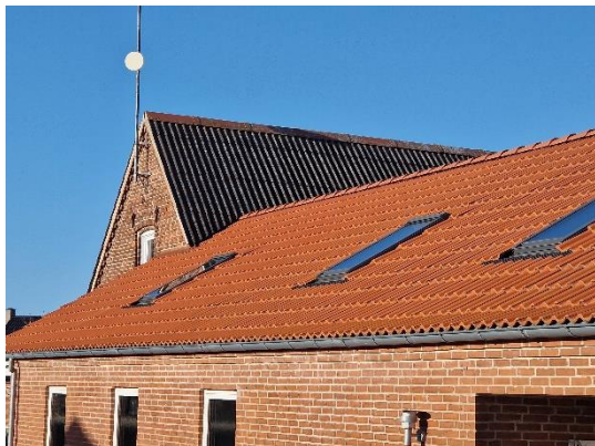
Solpaneller med batteri løsning
