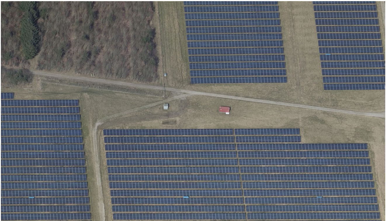
Eksempel på solcellepaneler i øst-vestgående rækker med gennemgående adgangsvej (billede fra NRGi Renewables projekt i Nees, Lemvig Kommune) - centralt i billedet ses mindre teknikbygninger, som svarer til de mindre teknikbygninger i solcelleanlægget ved Kolind. (SDFI, Skråfoto, 2021)
