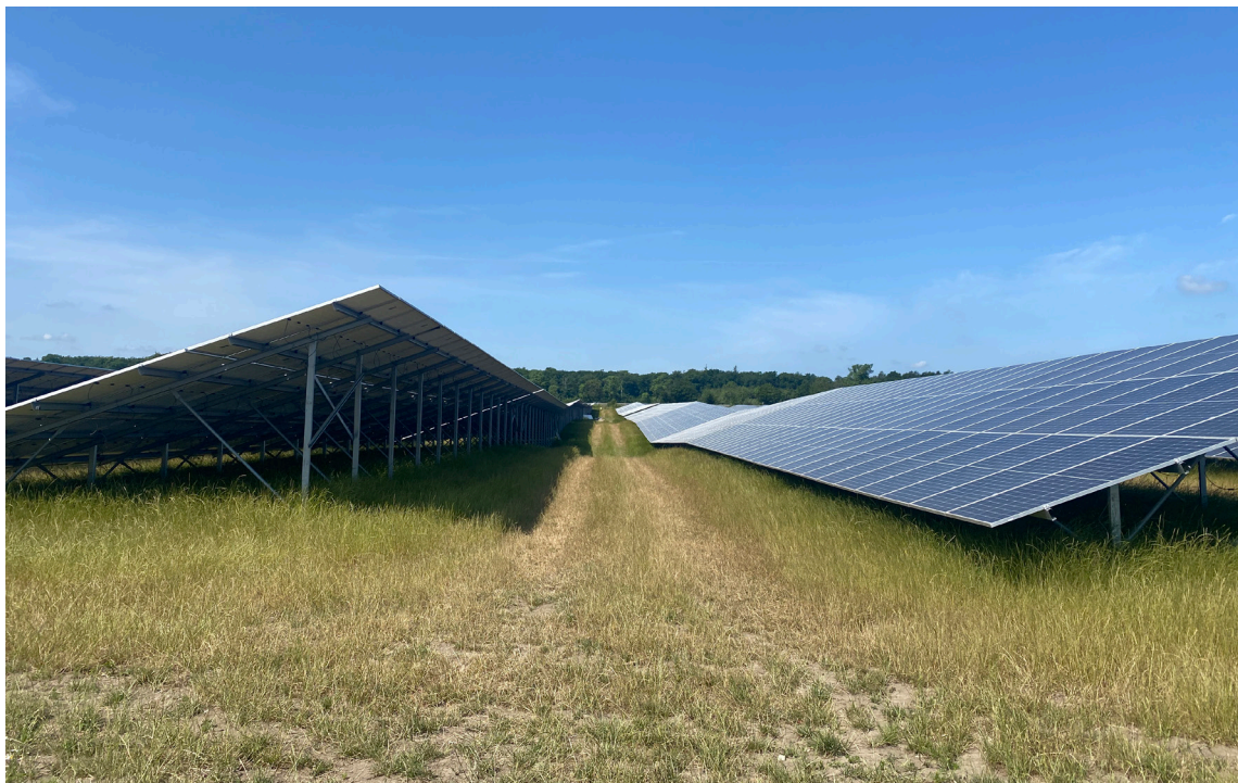
Eksempel på solcellepaneler på stativer med en højde på 3,5 meter.
