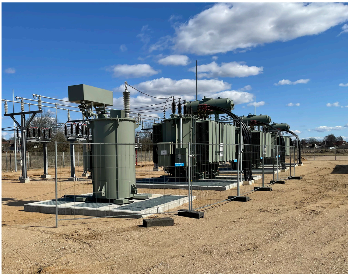
Eksempel på intern transformerstation (nettilslutningsanlæg) uden teknikbygning (NRGi Renewables).
