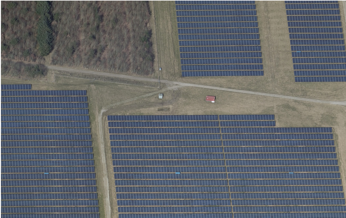
Eksempel på solcellepaneler i øst-vestgående rækker med gennemgående adgangsvej (billede fra NRGi Renewables projekt i Nees, Lemvig Kommune) - centralt i billedet ses mindre teknikbygninger, som svarer til de mindre teknikbygninger i solcelleanlægget ved Kolind. (SDFI, Skråfoto, 2021)
